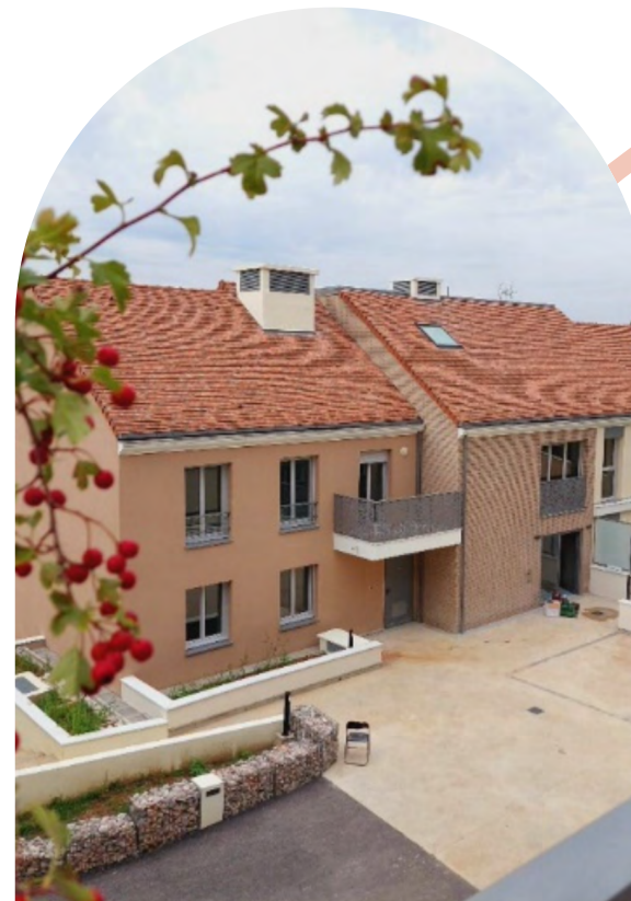
12 septembre 2022, livraison de 40 logements famille Maîtrise d'Ouvrage Directe (PLUS/PLAI/PLS) Sis 52-54 avenue du Général de Gaulle à VAUX SUR SEINE (78) Architecte : CUSSAC Architectes et Associés
